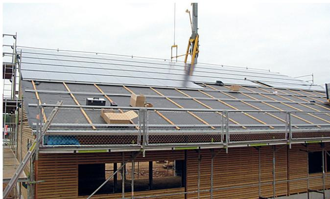
Pose de modules photovoltaïques en éléments de couverture.
