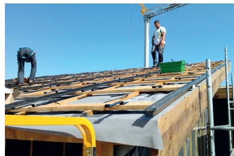
Profils drainants et crochets pour une pose en couverture (droite).
