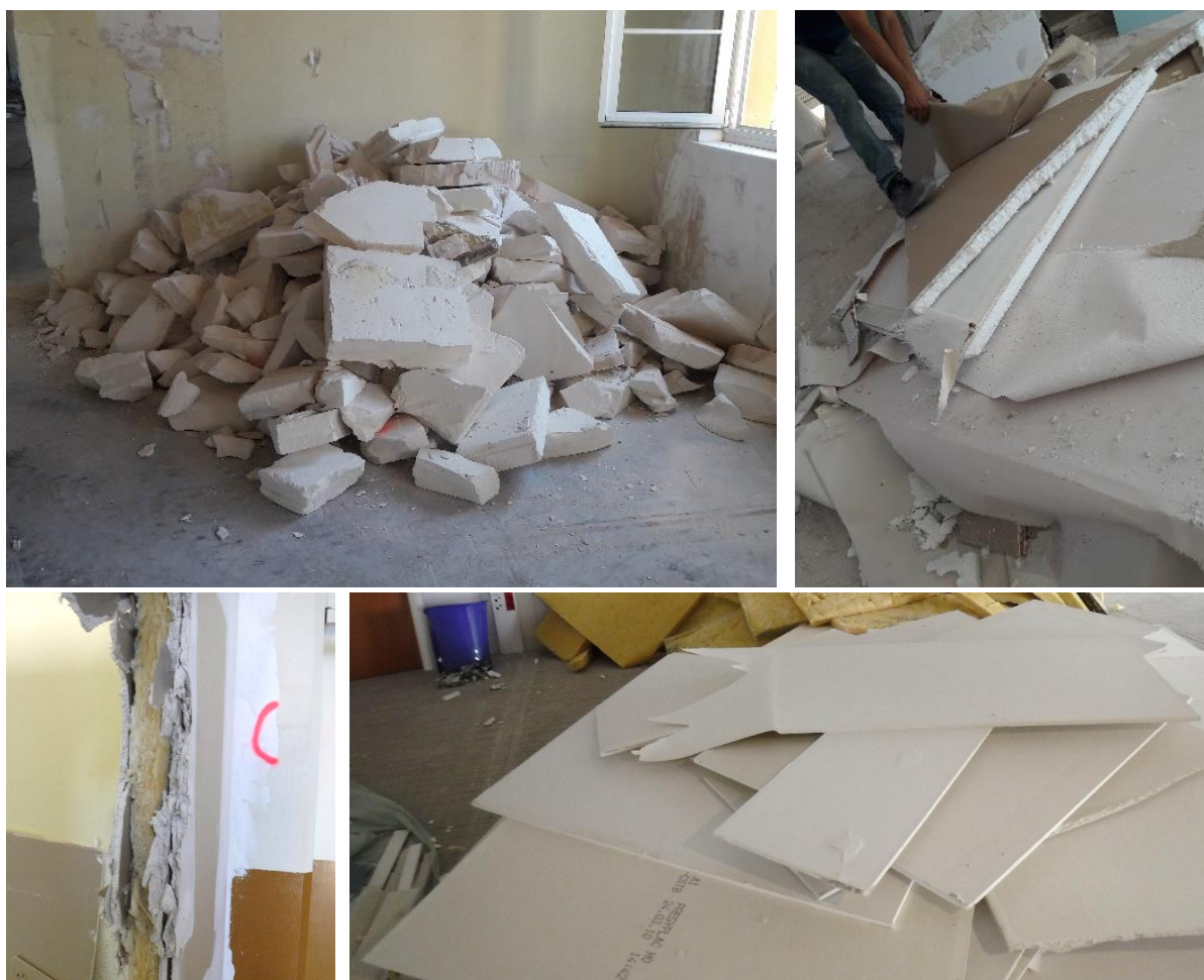
Figure 12 : exemples de déchets de plâtre triés sur les chantiers suivis dans le cadre de l'étude
