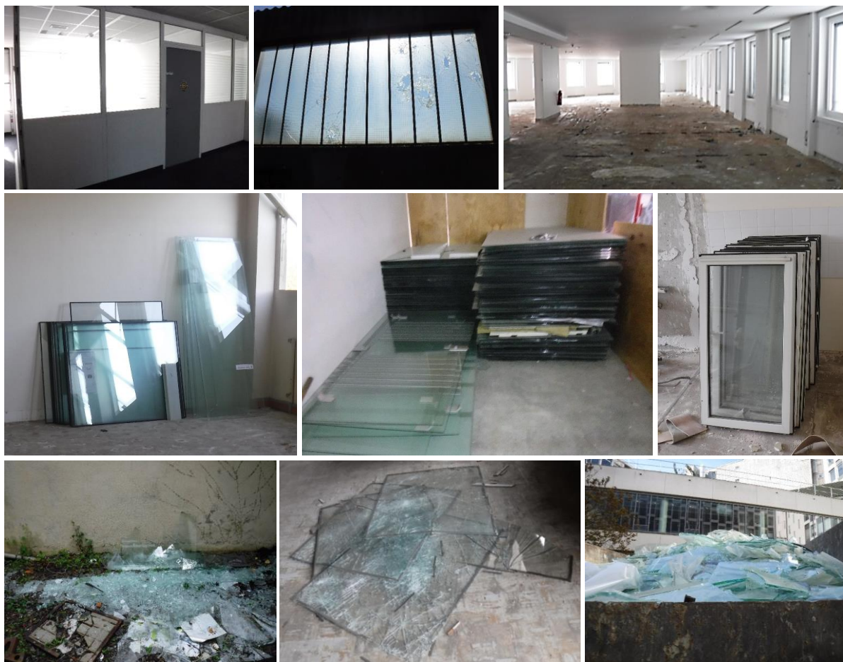
Figure 13 : exemples de déchets de fenêtres et verre plat sur les chantiers suivis dans le cadre de l'étude
