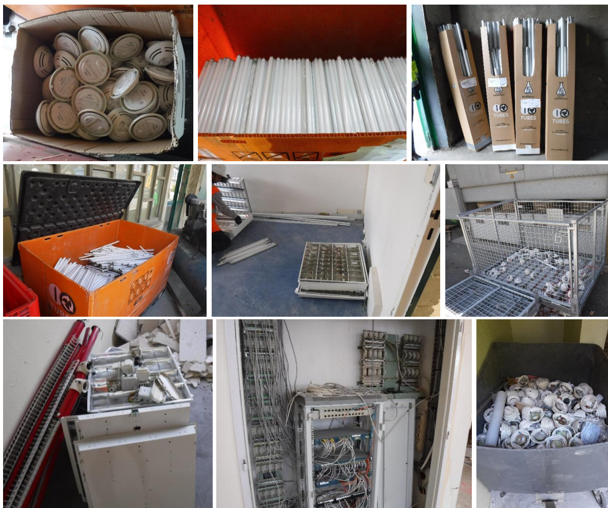
Figure 16 : exemples de lampes et déchets d'équipements électriques et électroniques sur les chantiers suivis dans le cadre de l'étude
