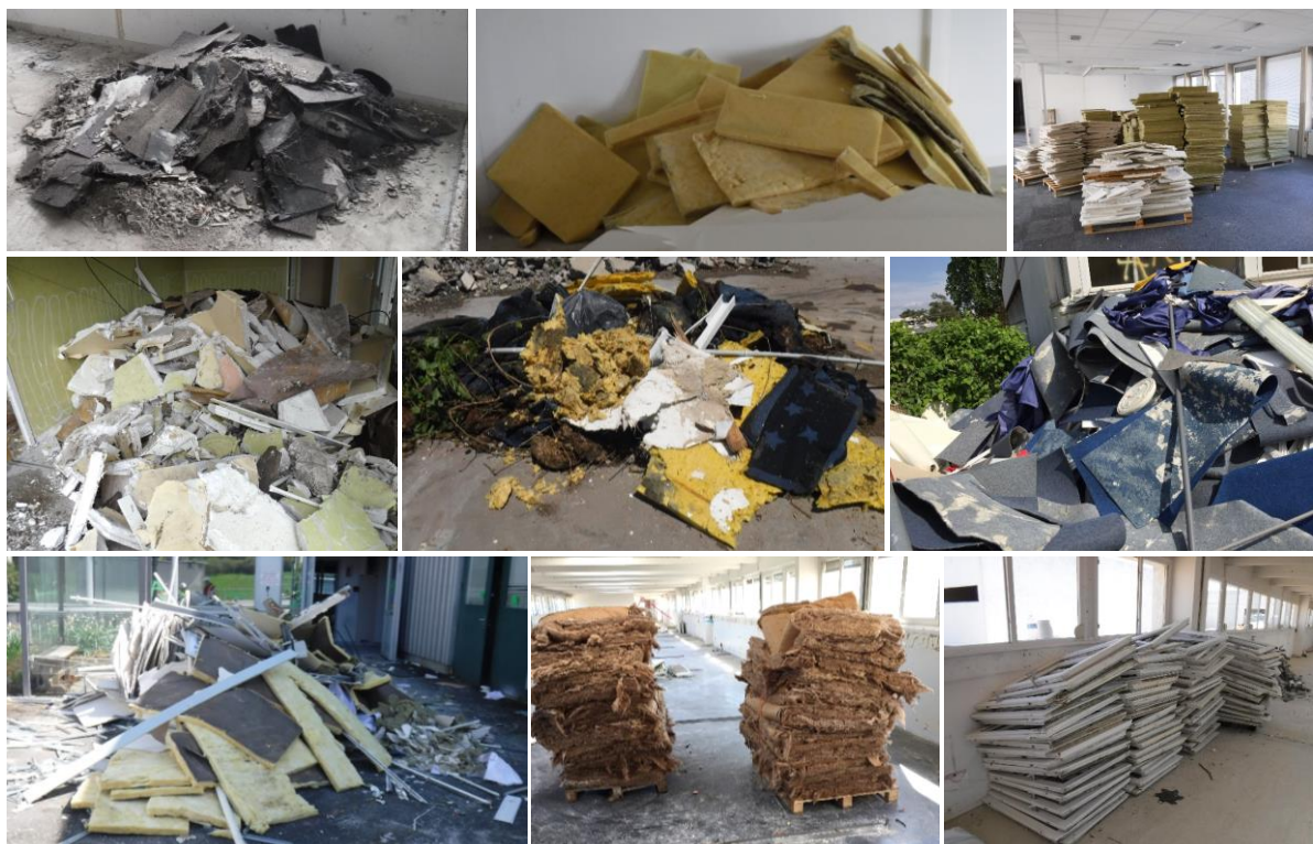
Figure 17 : exemples d'autres déchets non dangereux (non inertes), non triés sur les chantiers suivis dans le cadre de l'étude
