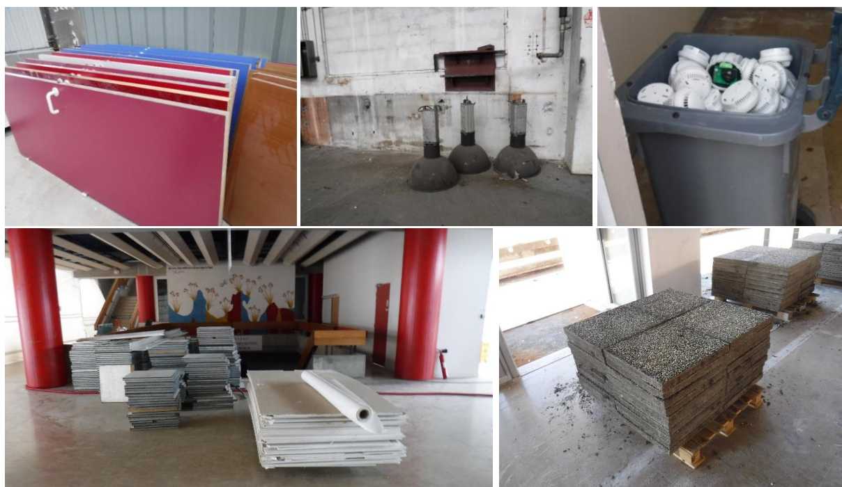
Figure 25 : exemples de produits déposés en vue d'un réemploi sur les chantiers suivis dans le cadre de l'étude
