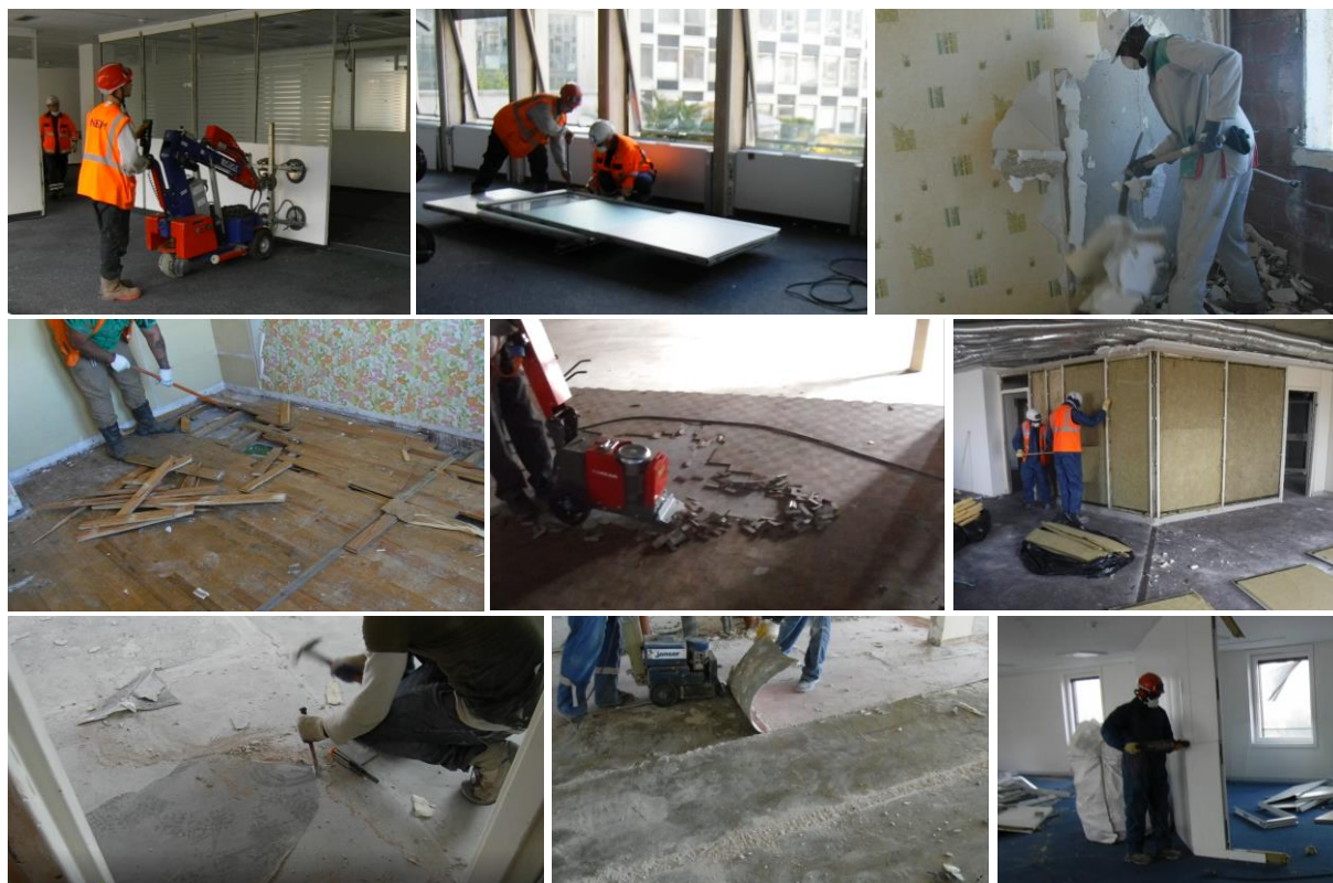
Figure 24 : exemples d'opérations de dépose manuelle/ semi-manuelle sur les chantiers suivis dans le cadre de l'étude
