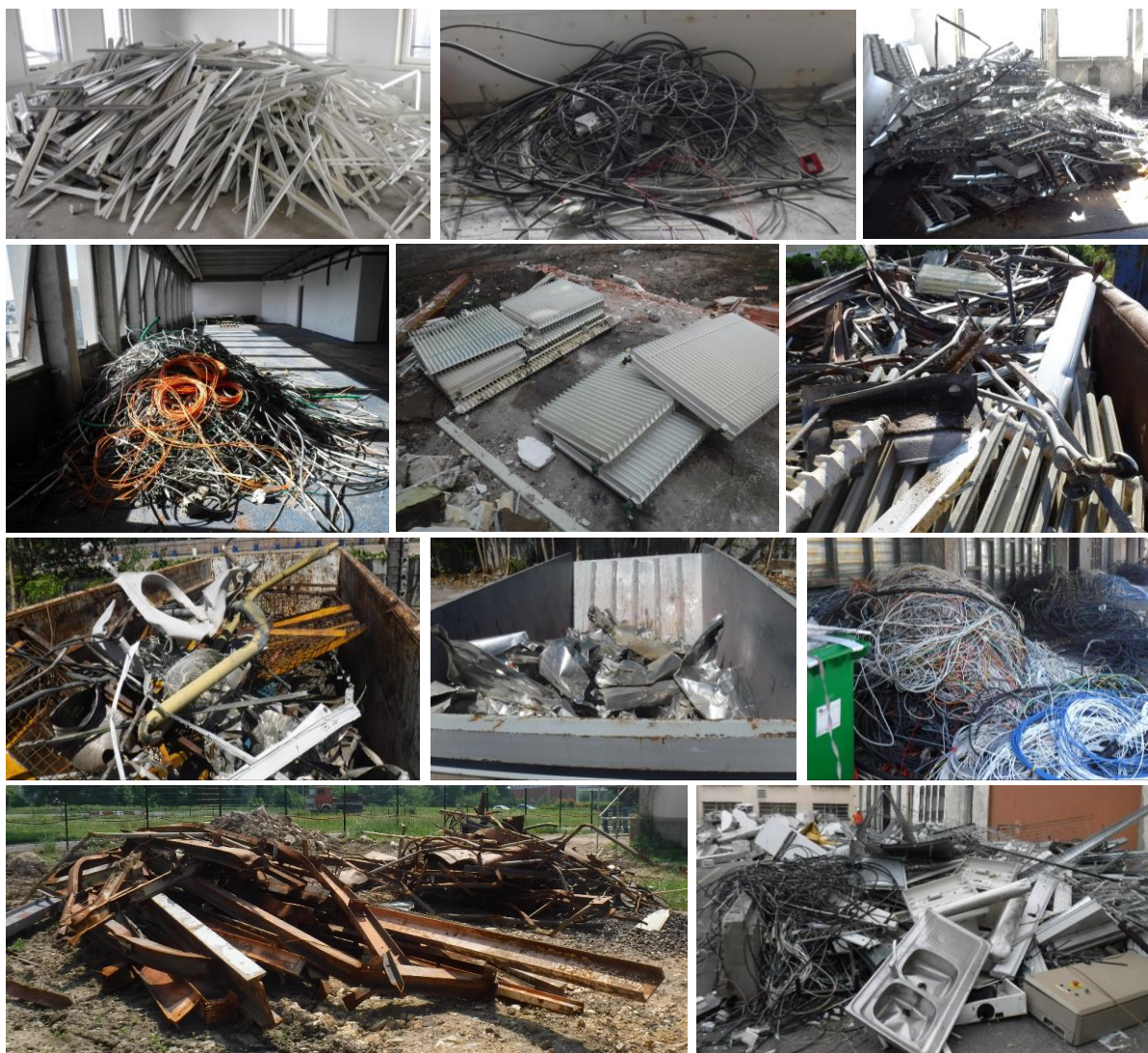
Figure 9 : exemples de déchets métalliques déposés sélectivement et triés sur les chantiers suivis dans le cadre de l'étude
