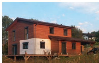
La Forge (88) Constructeur : Maison Gico
