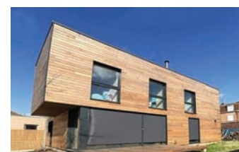
Roubaix (59) Bureau d'études : Energelio
