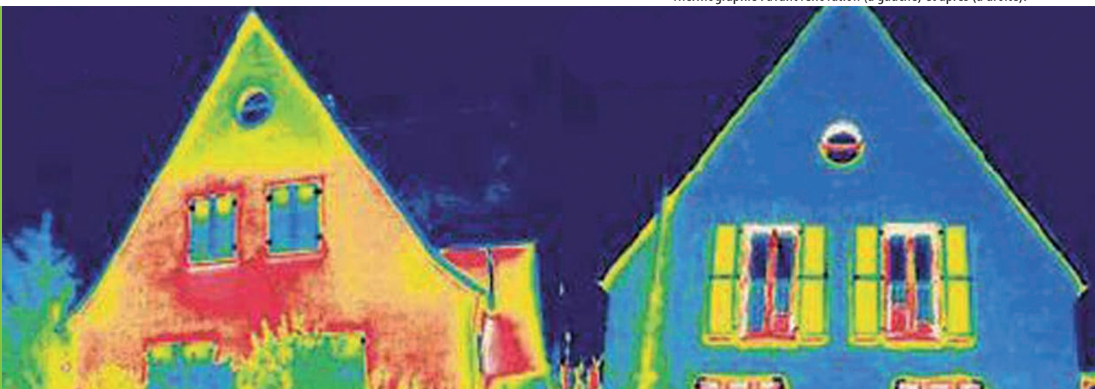
Thermographie : avant rénovation (à gauche) et après (à droite).
